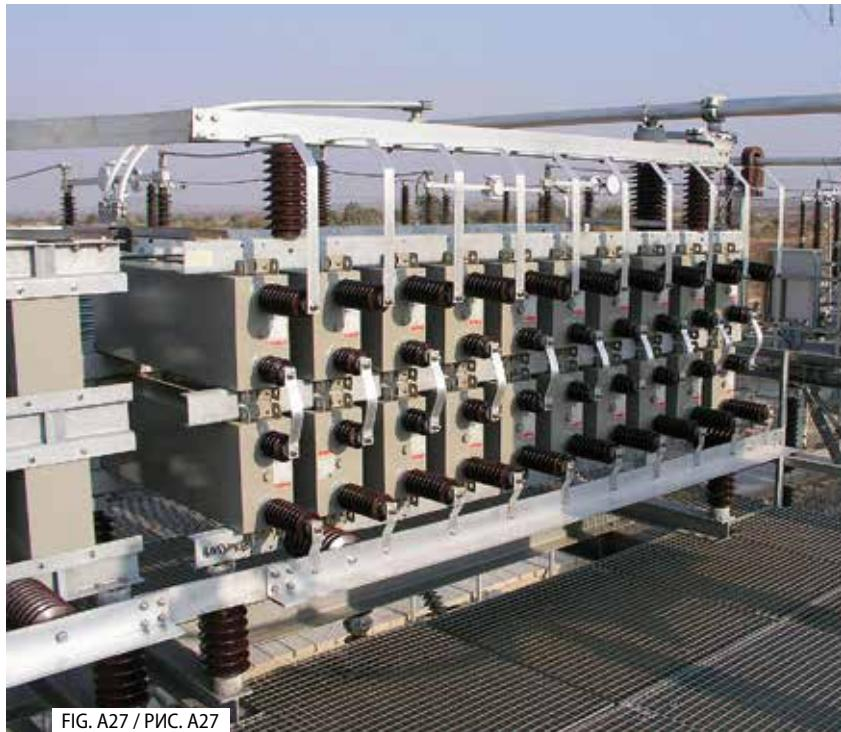
Banco condensatori 400kV-180Mvar-50Hz per compensazione serie composto da n°4 torri per fase(vista di una singola torre)
